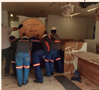
Instalação do equipamento já começou
