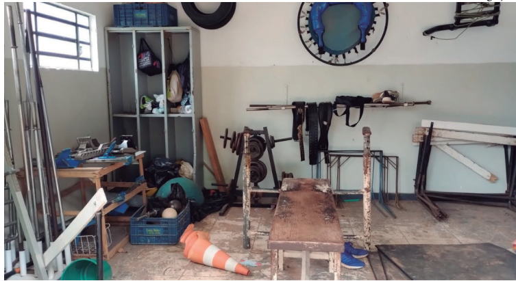
Local frequentado por atletas aparece nas imagens com mau estado de conservação
