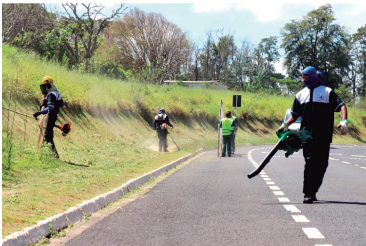
Trabalhadores durante capinação; avenida João Ramalho já recebeu os serviços
