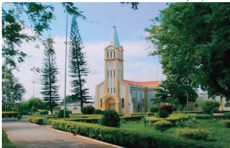
Paróquia de Santo Antonio, em Alvinlândia, ao fundo; recursos para reforma do local
