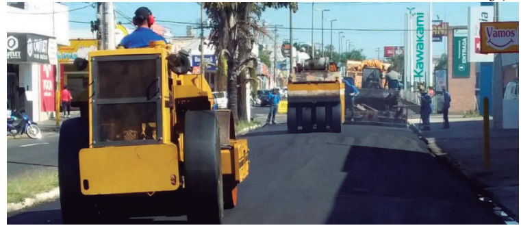
Serviços de reapecamento asfáltico estão previstos para serem realizados em toda a cidade
