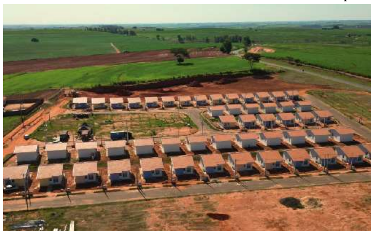
Conjunto habitacional foi construído em duas etapas; futuros moradores aguardam entrega
