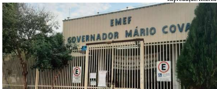
Vista da escola municipal, que tem ampla reforma, mas com prazo de execução atrasado
