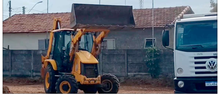
Maquinários estão fazendo a terraplanagem no terreno de obras do Bandeirante
