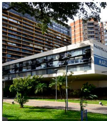
Prédio do Paço Municipal está em reforma
