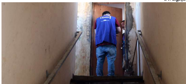
Moradores foram retirados dos prédios interditados por risco de desabamento
