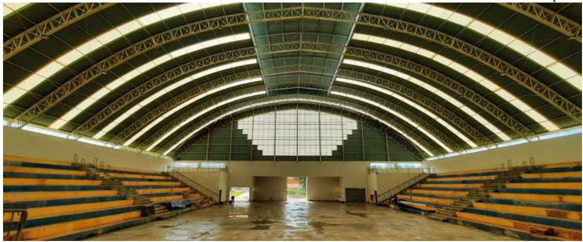
Imagem do ginásio coberto distribuída à imprensa pela prefeitura em maio de 2024; reforma começou em abril de 2022
