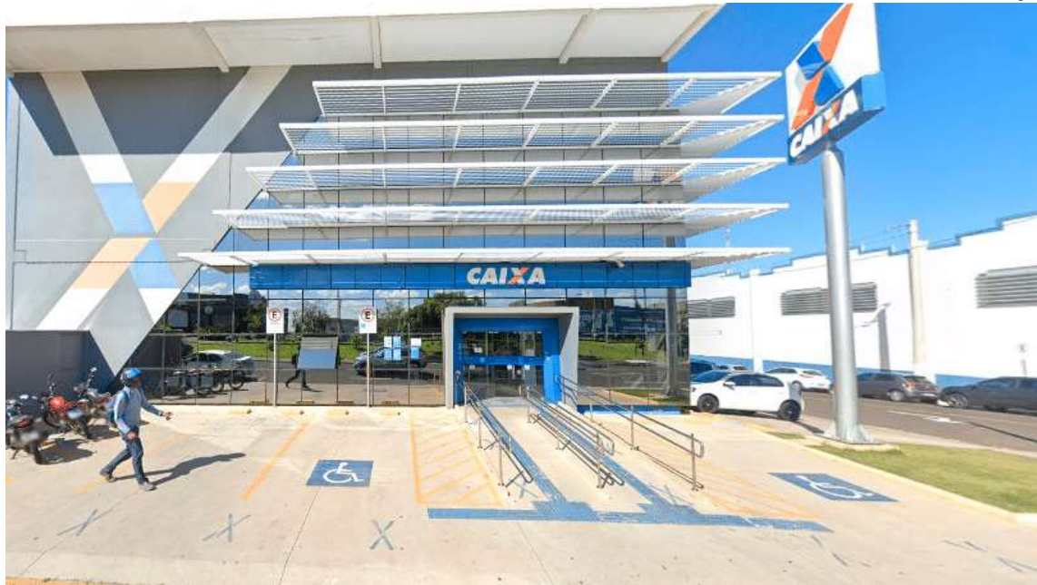
Agência da Caixa Econômica Federal localizada na avenida das Indústrias, em Marília; mudanças começam em novembro
