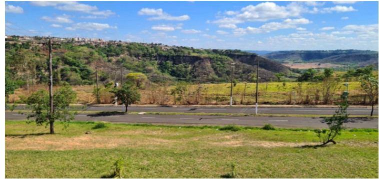
Área que receberá as obras possui 3,9 mil m 2 e está localizada na Via Expressa Sampaio Vidal, em Marília
