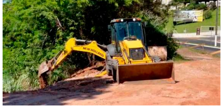
Máquina em trabalho de contenção de erosão; avenida recebe recapeamento
