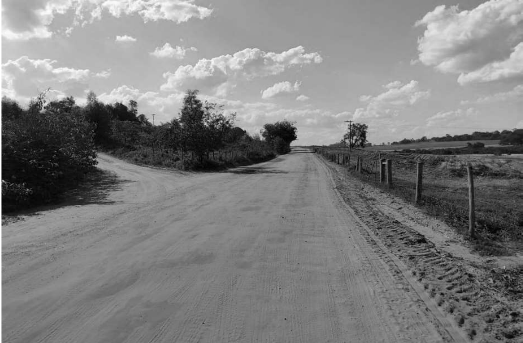
Estrada municipal vai receber investimento de R$ 1 mi para pavimentação
