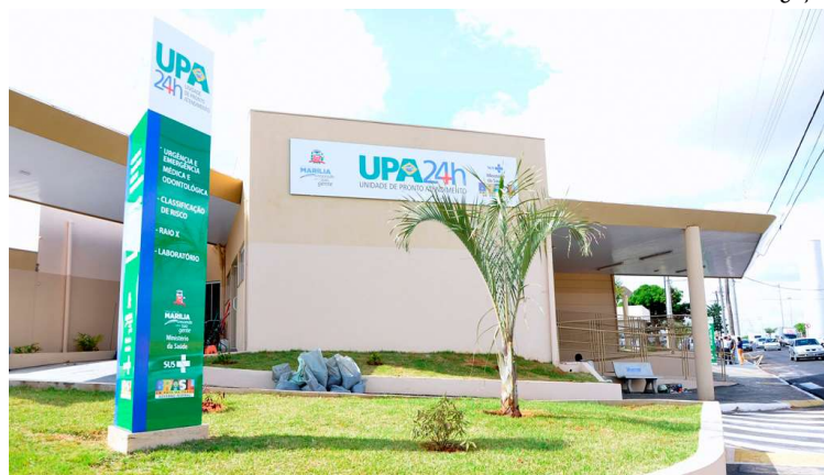
Melhorias serão realizadas na UPA Norte (na foto) e no PA da zona Sul de Marília
