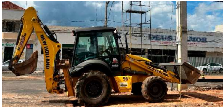
Trabalhos incluem novo piso com acessibilidade, pintura, iluminação e paisagismo
