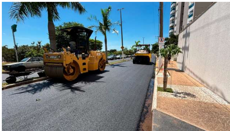
Segunda etapa de programa de recapeamento abrangerá diversas ruas e avenidas
