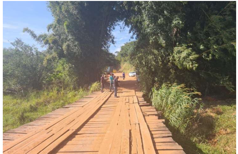
Ponte no distrito de Rosália está em obras para troca de elementos estruturais e peças
