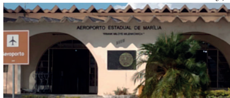
Aeroporto de Marília aguarda reforma; concessionária tem pedido rejeitado
