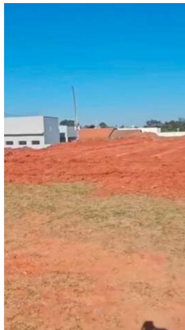
Obras ao lado da Academia Municipal
