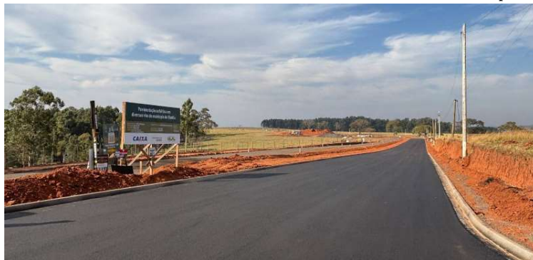
Trabalhos continuam a todo vapor para pavimentação de avenida da região Sul
