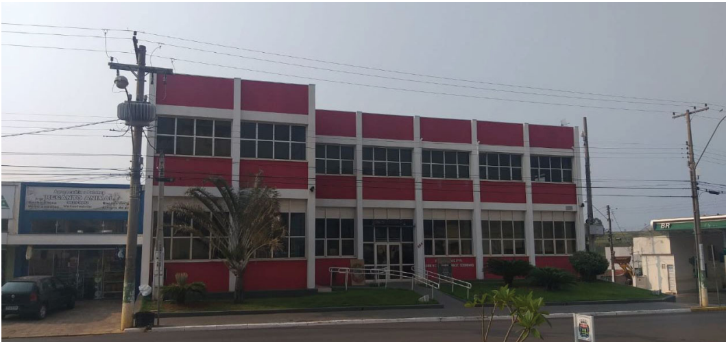
Vista da Prefeitura de Ocauçu; município licita serviços de pintura para prédios públicos
