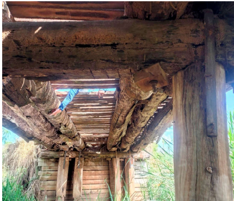
Manutenção da ponte está no cronograma de obras da Secretaria de Infraestrutura
