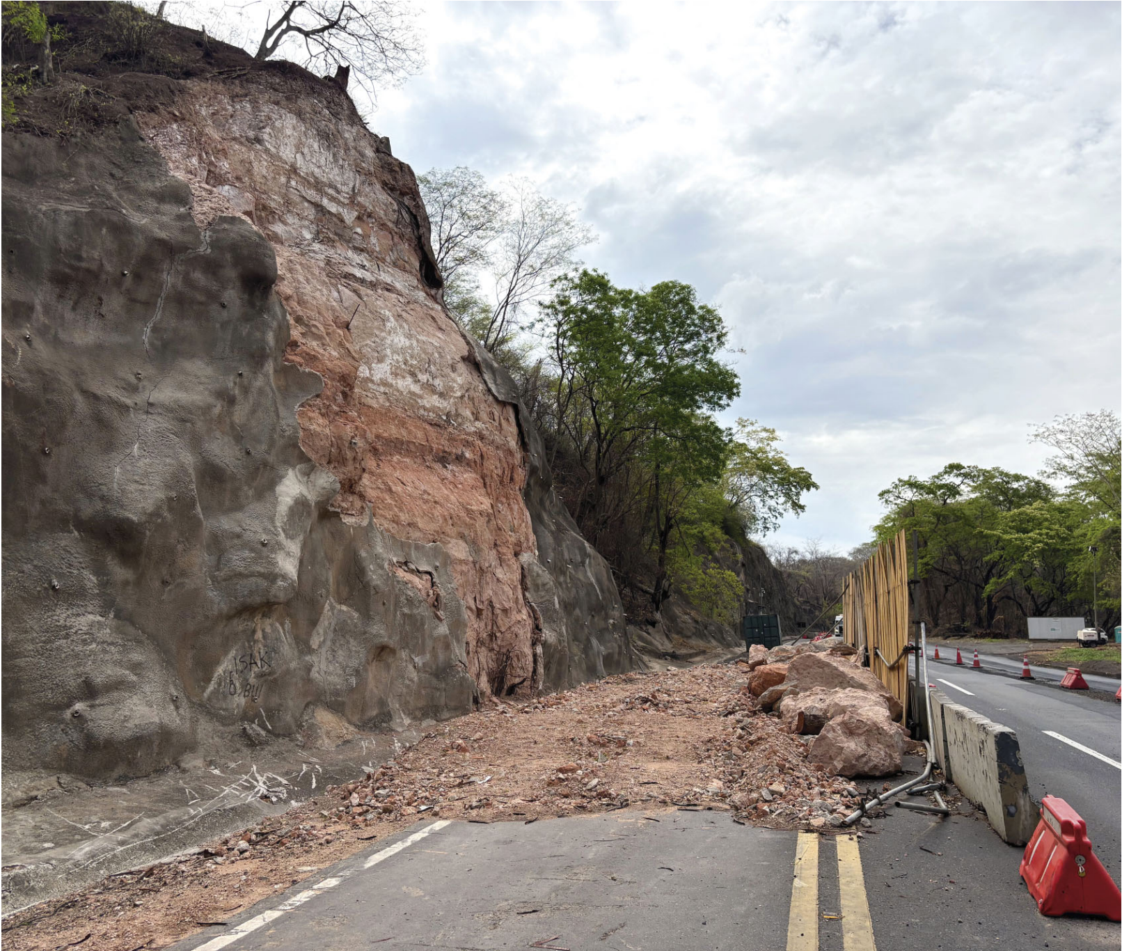
Intervenção, iniciada após o deslizamento em agosto, foi adiada até a conclusão da contratação da empresa responsável pela execução dos serviços
