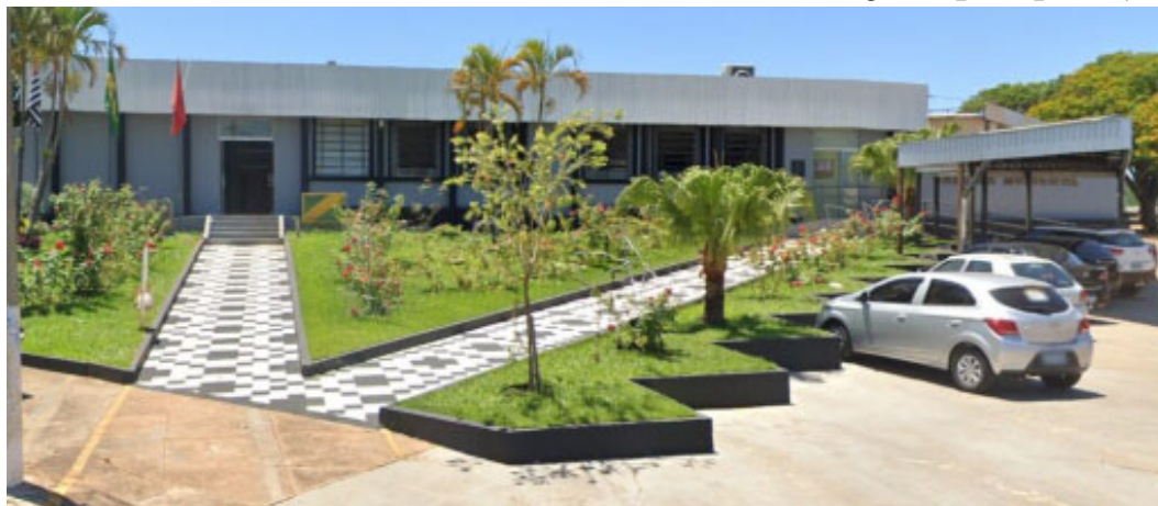
Prefeitura sancionou lei que extingue cargos, antes aprovada pela Câmara Municipal
