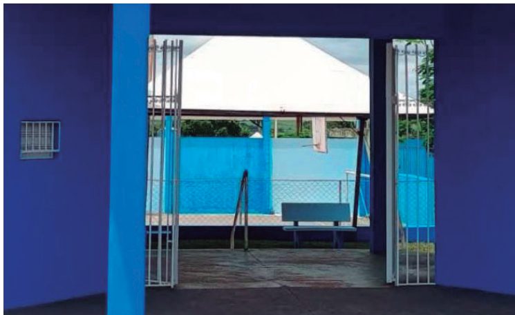
Centro Esportivo Ivan Giroto passou por reformas estruturais e adequações
