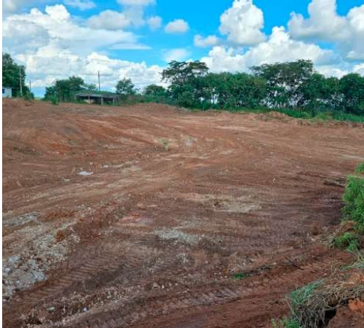
Novo aterro inicia operação em março
