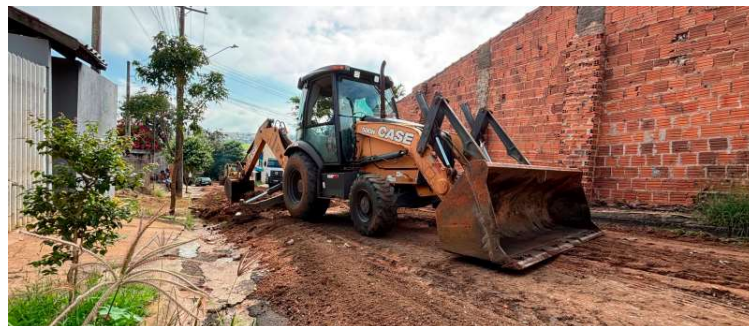
Equipes trabalham na preparação do terreno para receber infraestrutura e pavimento
