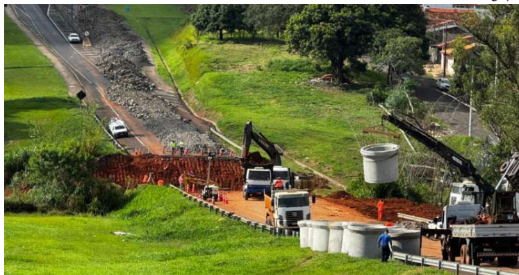
Obras de contenção na rodovia desviam o tráfego para novas rotas alternativas
