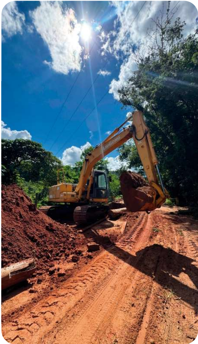
Serviços de manutenção contemplam ruas e estradas
