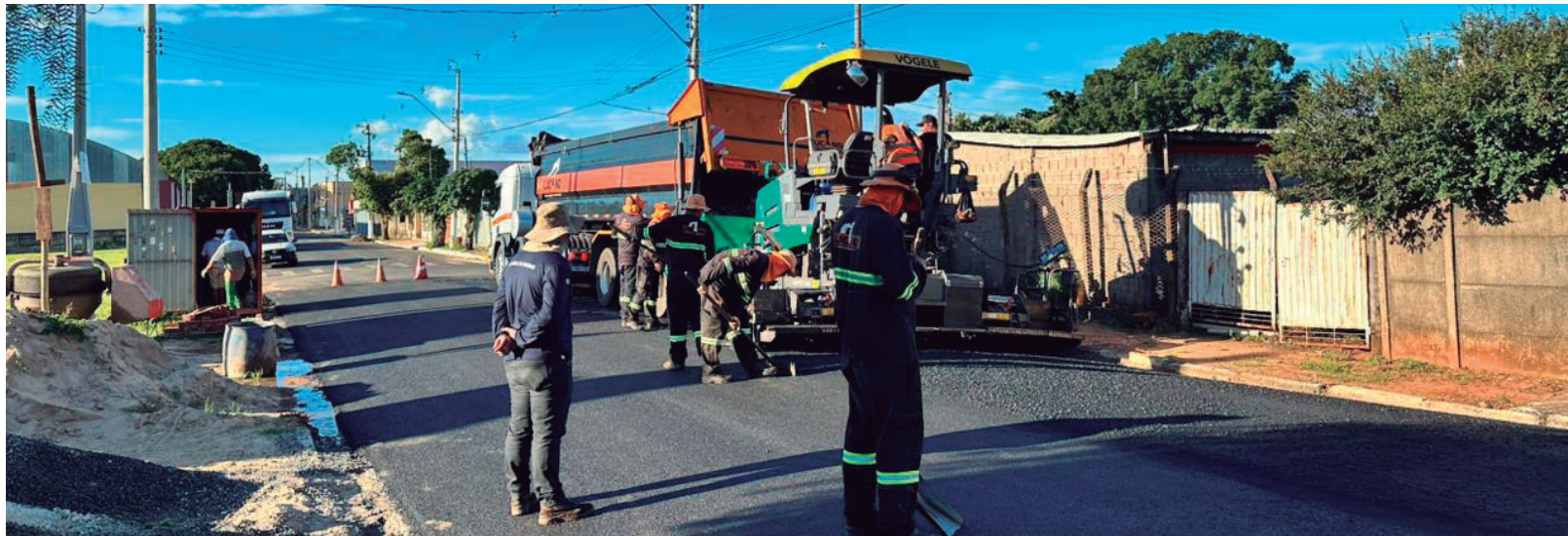
Obras de recapeamento asfáltico são realizadas em vias do município, com apoio de emenda parlamentar destinada
