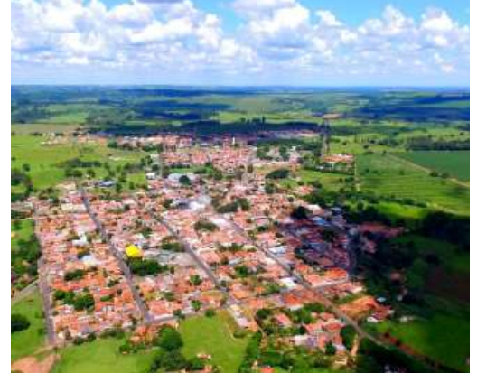
Intervenção melhorará drenagem urbana
