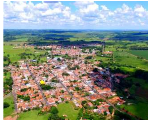
Intervenção melhorará drenagem urbana
