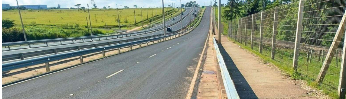
Um dos pontos onde serão instaladas lombadas; marginais foram entregues em 2024 com a duplicação na região de Padre Nóbrega
