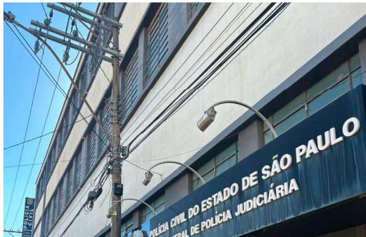
O caso foi registrado como furto qualificado, com rompimento de obstáculo
