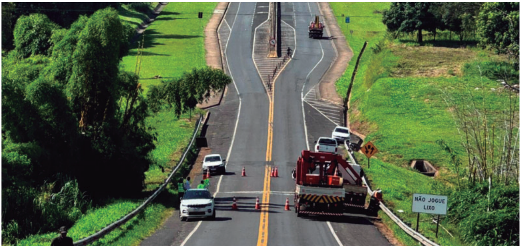
Interdição de trecho da rodovia altera fluxo de veículos; Emdurb se mobiliza
