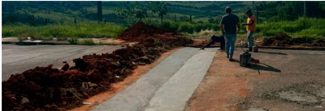
As equipes atuaram no cruzamento da rua João Zanguetin com a avenida Brasil, onde foi executada a abertura de uma valeta
