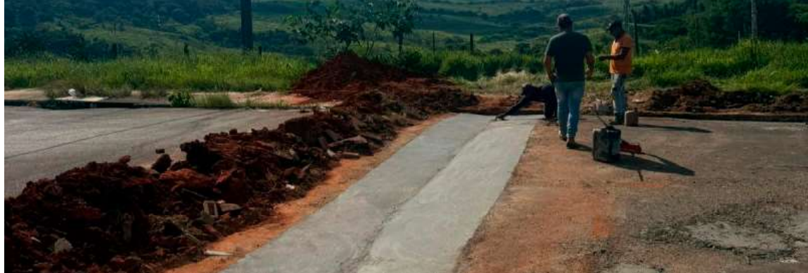
As equipes atuaram no cruzamento da rua João Zanguetin com a avenida Brasil, onde foi executada a abertura de uma valeta
