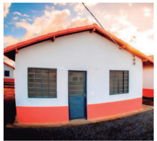
Autorização garante início das obras
