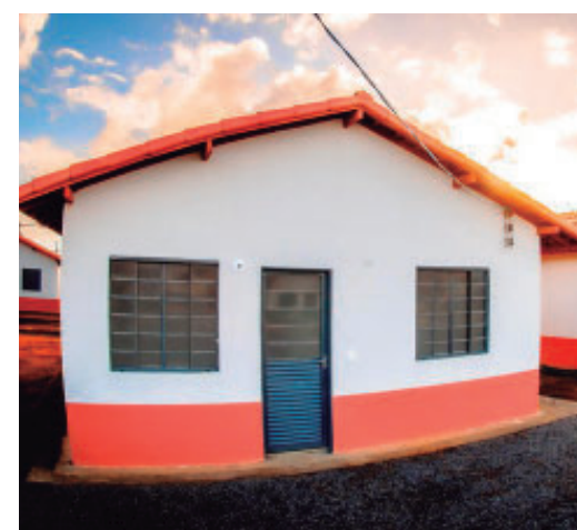
Autorização garante início das obras
