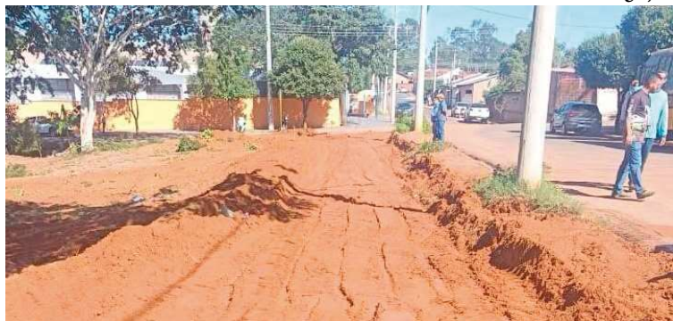
Serviços estão concentrados na terraplanagem e no nivelamento do terreno
