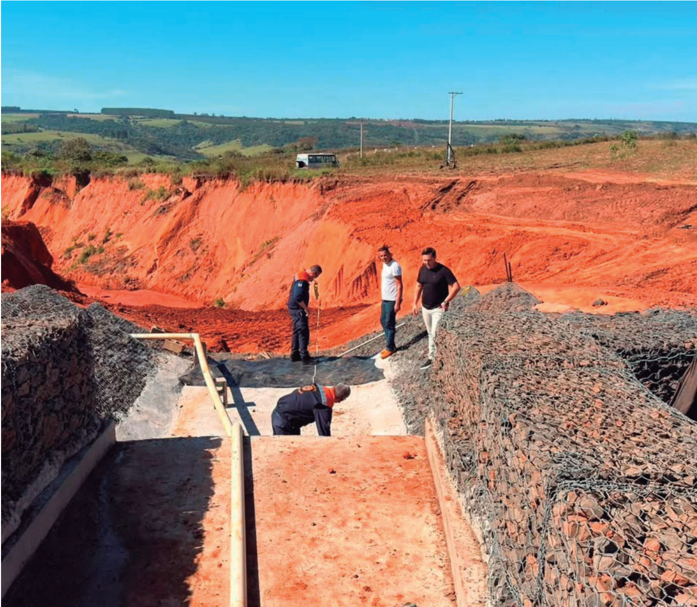
Obra de contenção está sendo executada de acordo com o projeto aprovado, segundo a Defesa Civil do Estado
