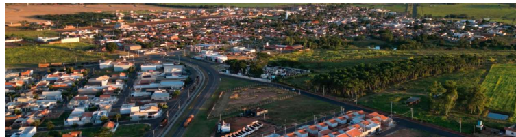
Município prepara estrutura para o Distrito Industrial; edital está disponível
