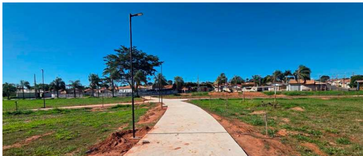
Trechos de calçamento estão concluídos e postes já foram instalados no local
