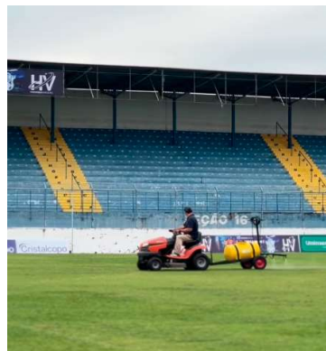
Trabalhos já tiveram início no campo
