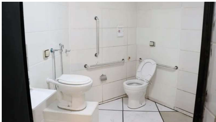
Adequações foram concluídas nesta semana e já estão disponíveis ao público
