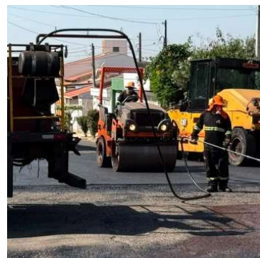
Programa Asfalto Novo já teve início
