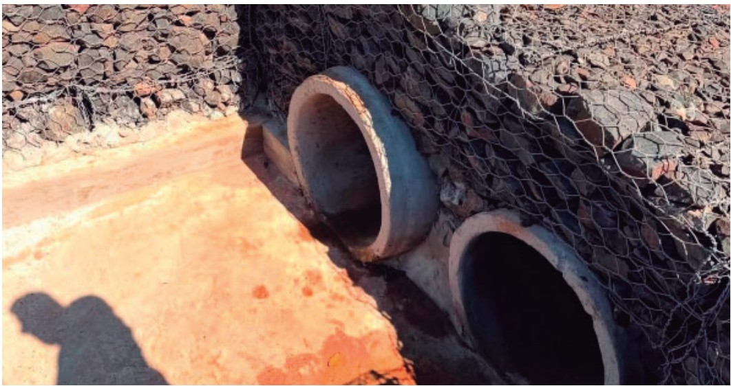
Vigência do contrato segue até 2027, mas expectativa é de que obra termine antes
