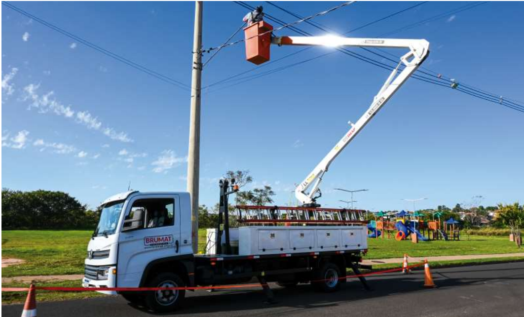
Trabalhos fazem parte de um processo de recuperação do sistema de iluminação
