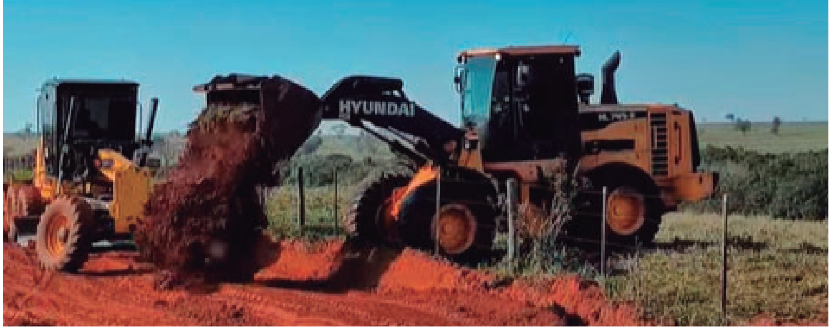
Trabalhos mobilizaram máquinas e servidores da administração municipal; sitiantes também colaboraram com retirada de terra
