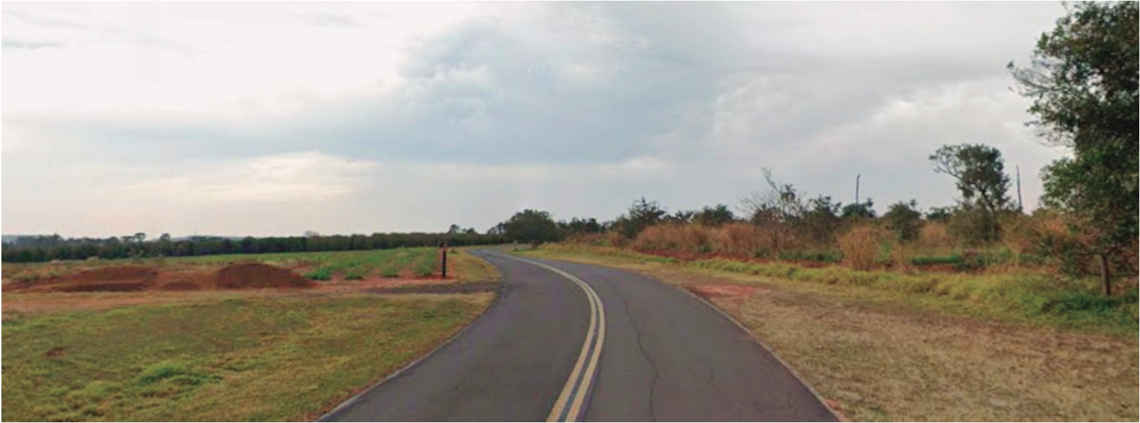
Estrada Vicinal AVL-020 é foco de ofício enviado pelo prefeito Júnior Moraes ao DER-SP; tratativas em andamento
