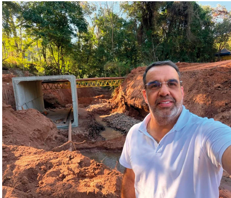
Moris visitou a obra; estrutura deve contribuir para escoamento da produção agrícola
